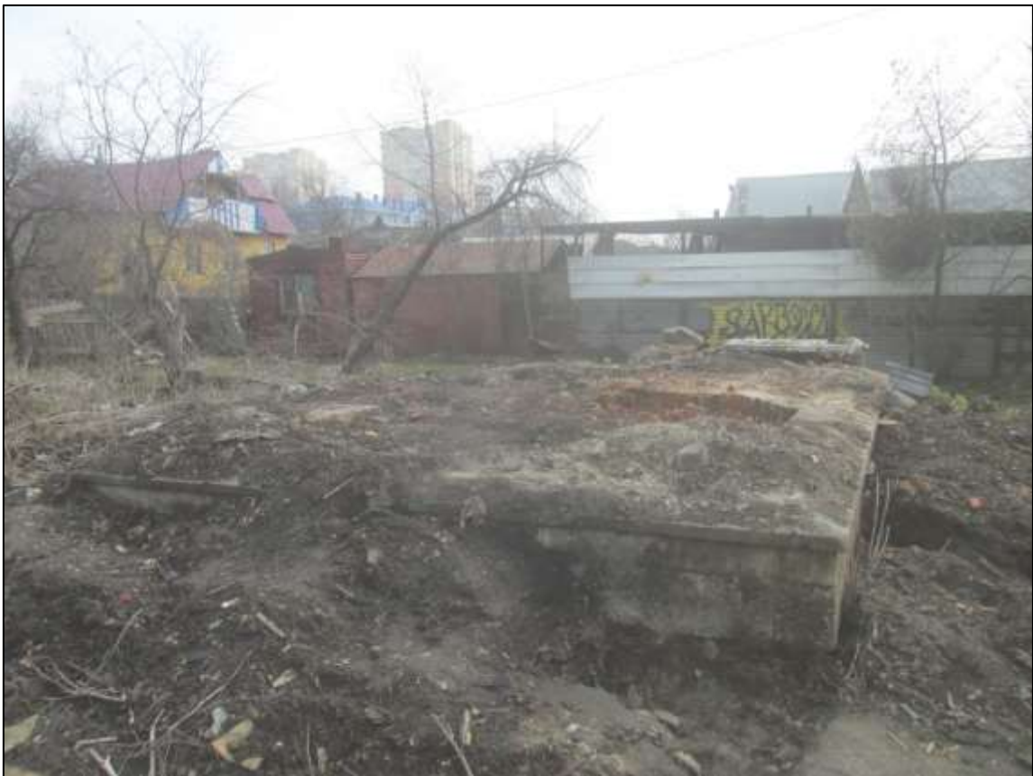
Цоколь водоразборной будки 2017 год
